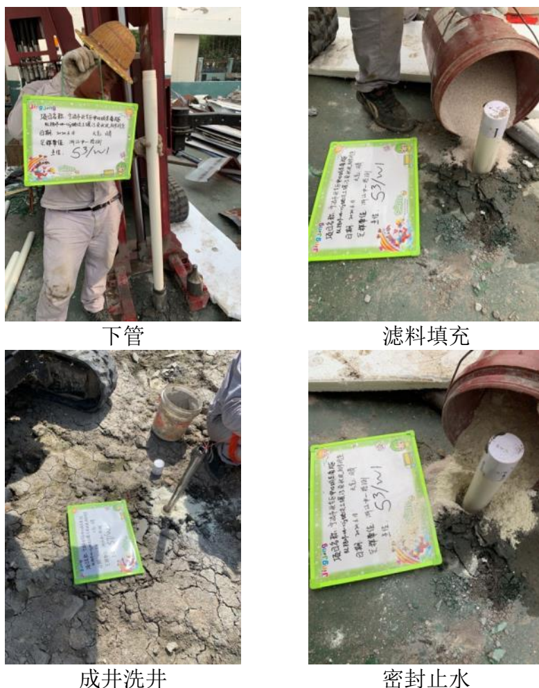
图 6.3 地下水现场建井照片
