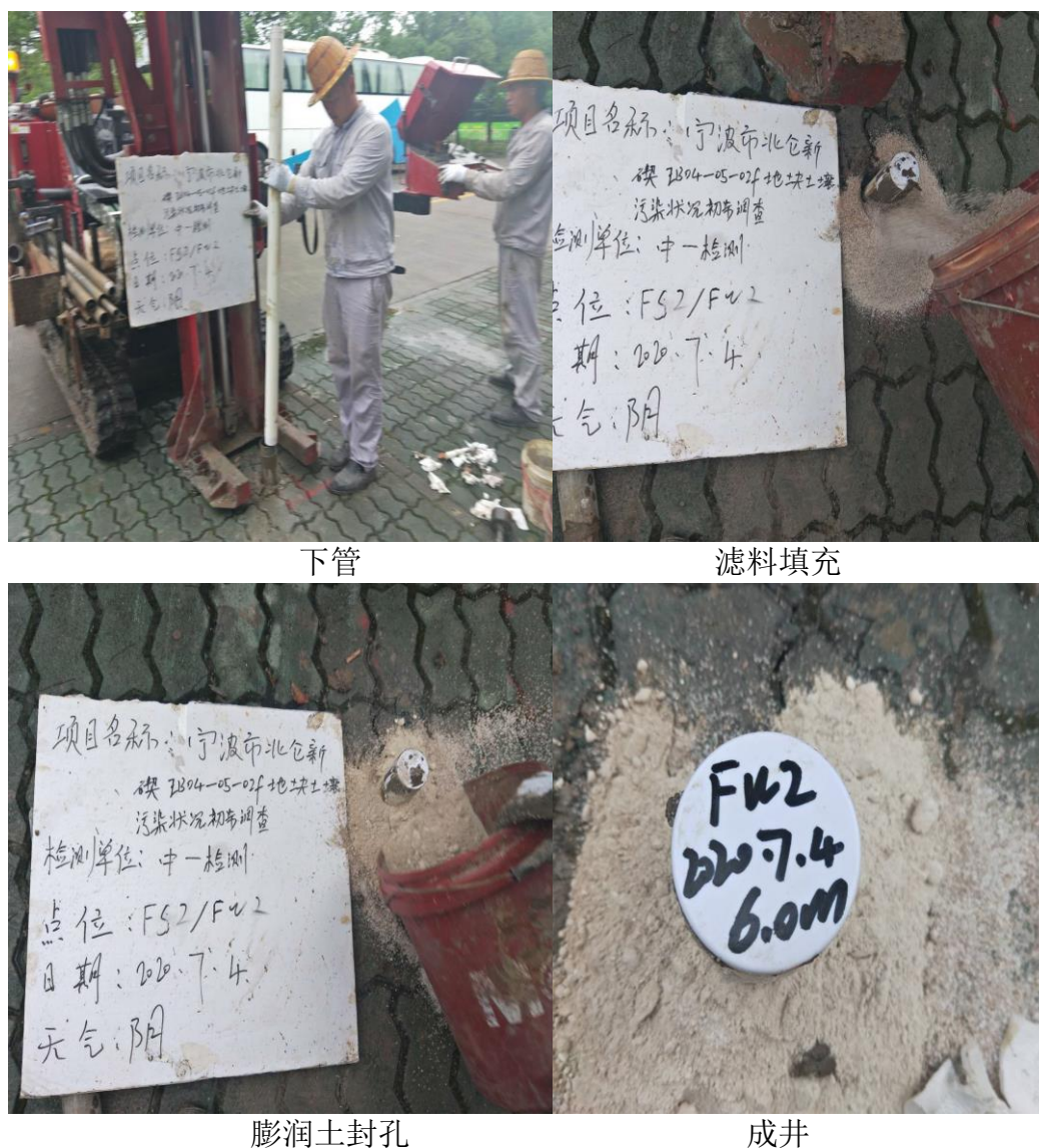
图 6-3 地下水现场建井照片
